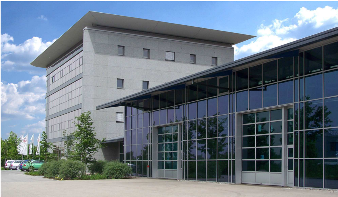
YOW! in Wolnzach - Blick auf Lagerhalle und Bürogebäude
